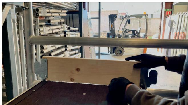
3. Coloque a primeira prancha longa, inclinando-a para facilitar a fixação, como mostra a foto 2.
