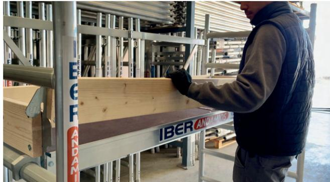
4. Ancla la chapa de unión del largo con la chapa de unión del tablero del ancho.
