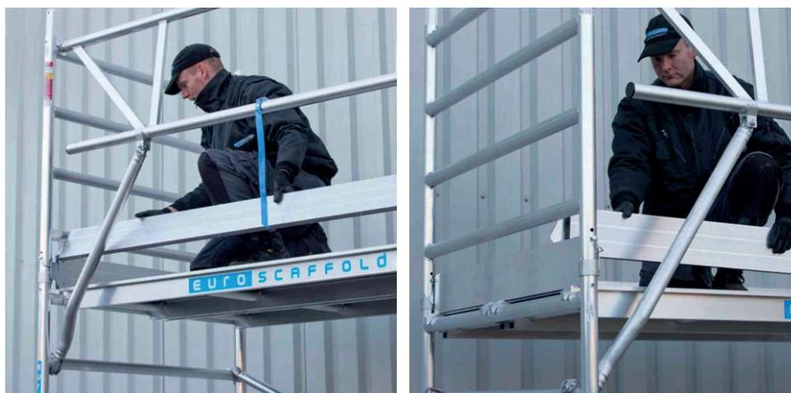
A desmontagem efectua-se pela ordem inversa, começando pelo rodapé.
